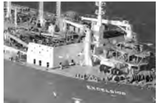
図表 39 Excelsior LNGRV Regasification Plant
