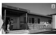
▲開設仮診療所 市立病院の仮設診療所を被災者支援として開設地区の仮設住宅団地に設置しました。
