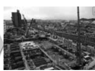
▲工事の様子（平成27年3月頃） 新市立病院建設地は石巻駅南とし、建設工事に着手しました。
