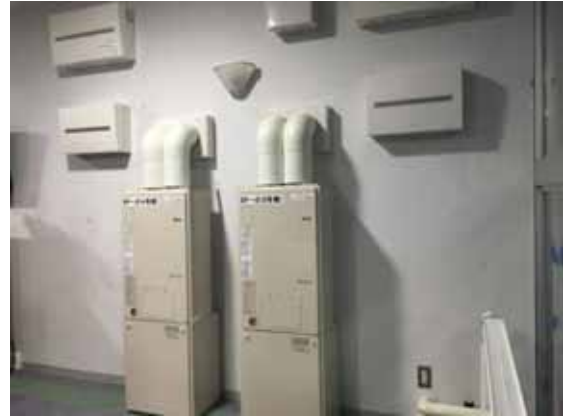
図表 5 - 14 入江運動公園温水プール 館内
