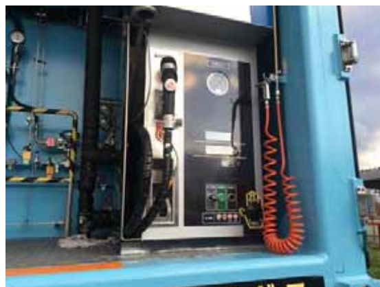
図表 5 - 12 ステーション内の様子
