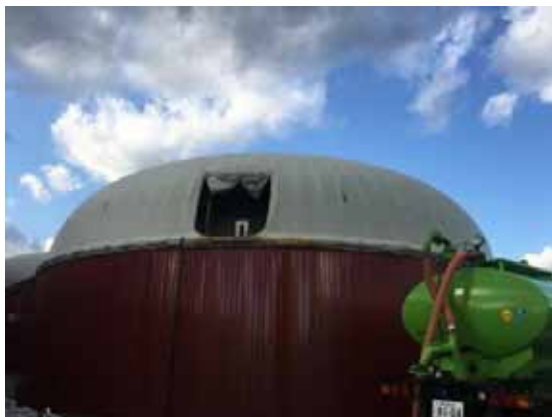
図表 5 - 21 メタン発酵施設
