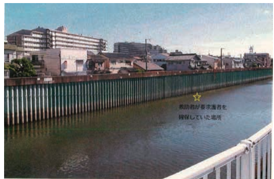
▲ 救助現場付近の寝根川（戎大黒橋の北西側から撮影）
