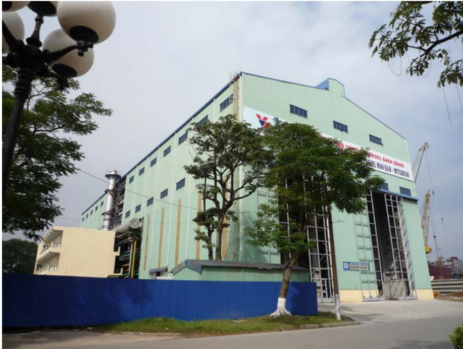
写真 6 バクダン造船所内のエンジン建屋（外観）
