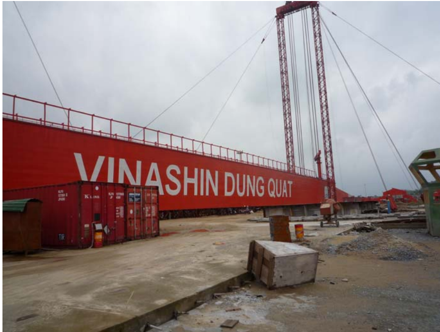
写真 21 No.1 乾ドックに据付中の 350 t 門型クレーン
