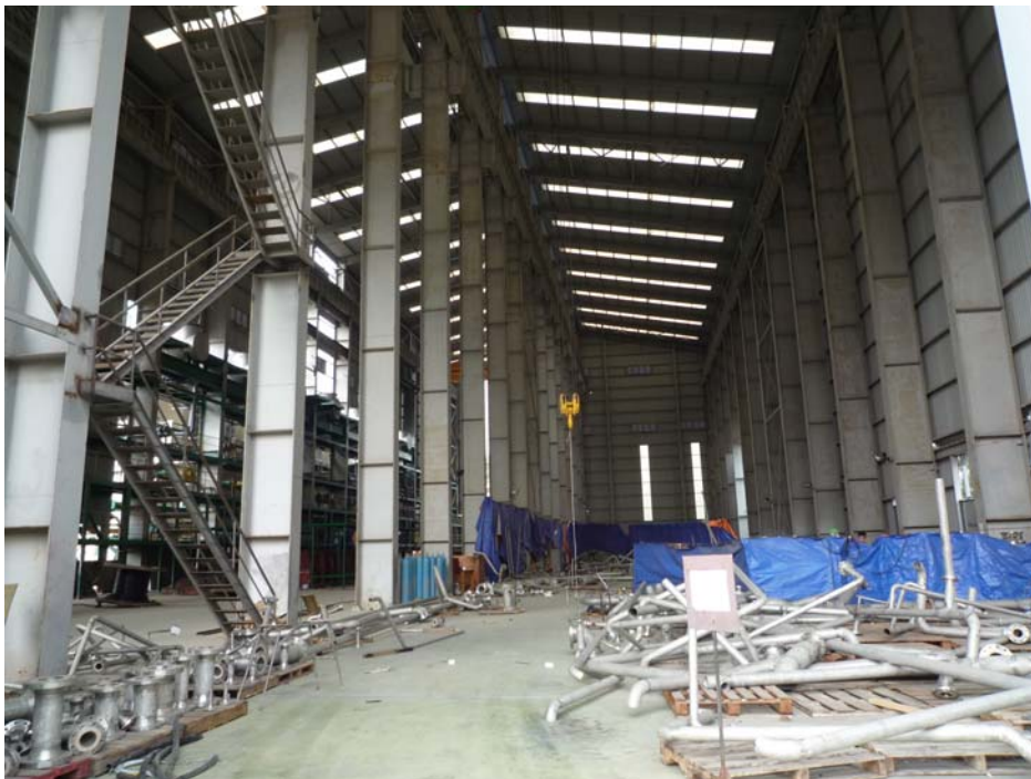
写真 8 エンジン建屋内部
