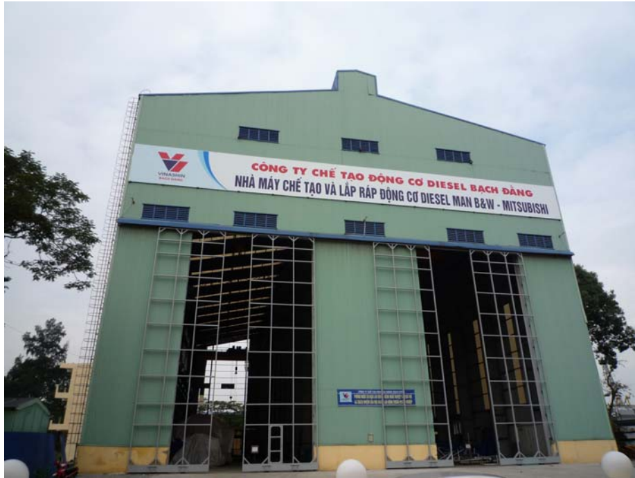
写真 7 エンジン建屋（出入口のドアは未完成）
