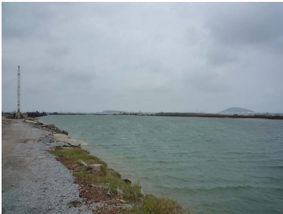
写真 20 乾ドック (520×110×14、建設中)
