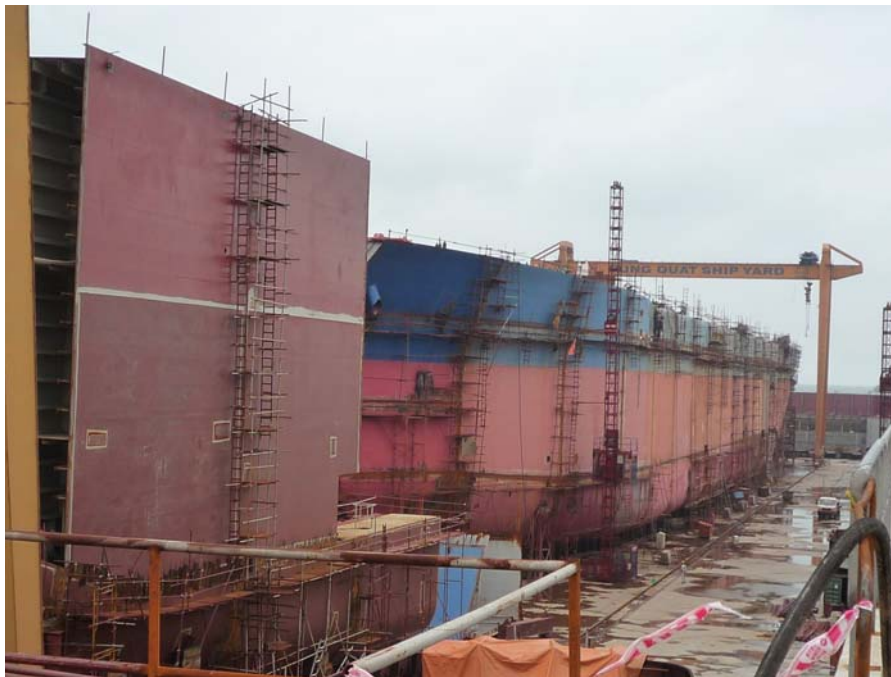
写真 4 建造中の10万4千DWT 1号タンカー
