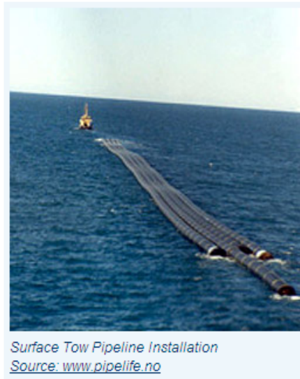
写真 水上曳航（surface tow）によるパイプラインの設置
