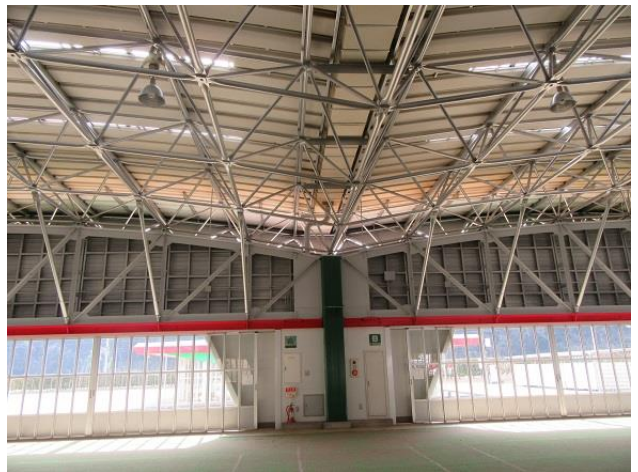
ゲートボール場上部トラス
