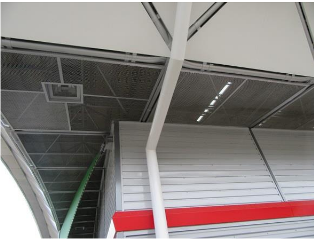
ゲートボール場縦樋及び軒サッシ
