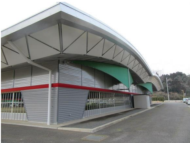
ゲートボール場軒天パネル及び縦樋
