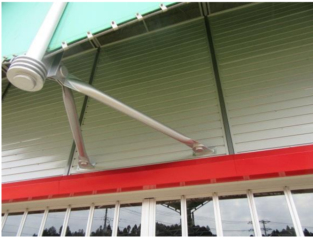
ゲートボール場テント支柱
