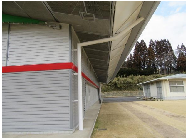
ゲートボール場縦樋
