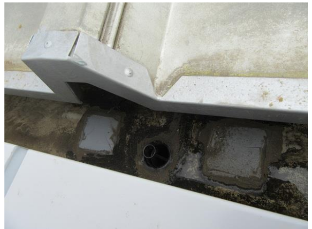
クラブハウス屋根樋（雨水排水溝）
