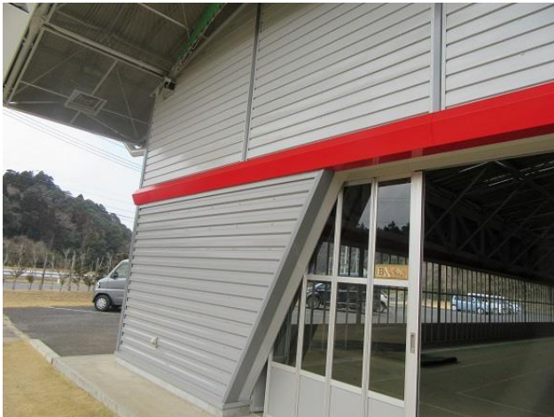
ゲートボール場外面パネル及びボーダー部分
