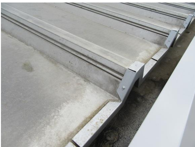
クラブハウス屋根樋（雨水排水溝）
