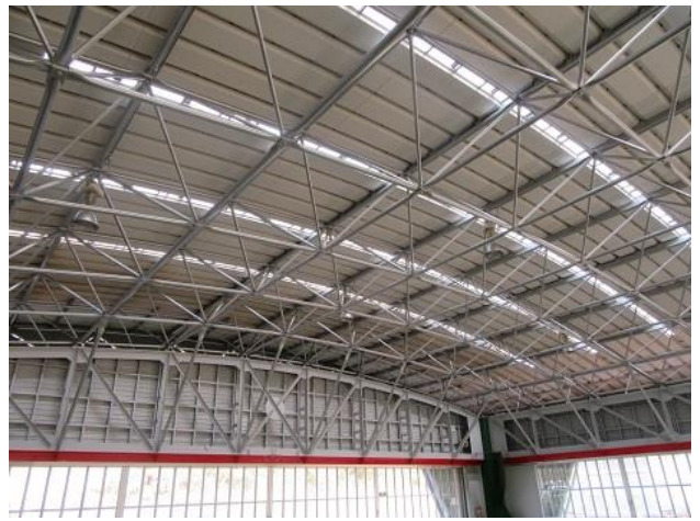
ゲートボール場上部トラス
