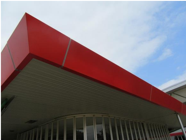
クラブハウス軒天及び軒天幕板
