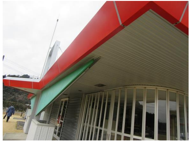
クラブハウス軒天及び軒天幕板
