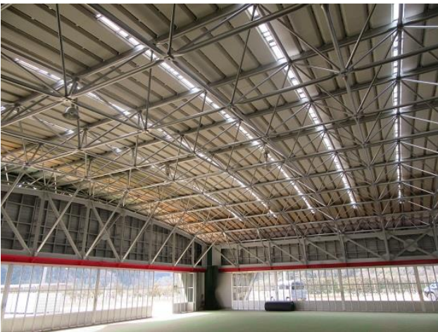
ゲートボール場上部トラス
