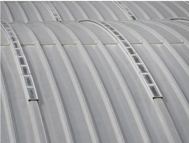
ゲートボール場屋根 (トップライト部分)
