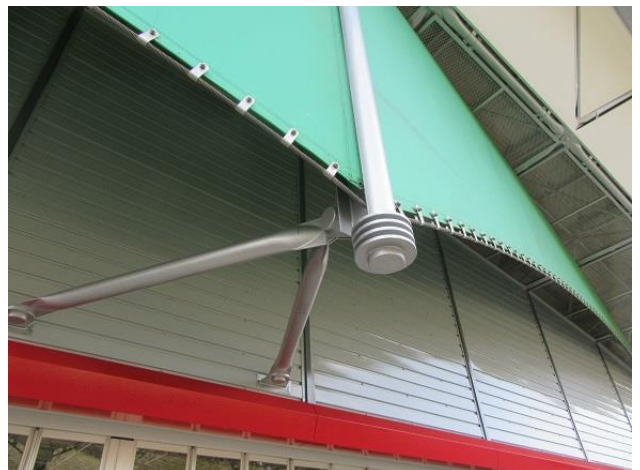
ゲートボール場テント支柱
