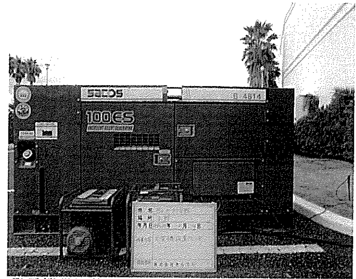
発電機設置状況
