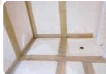
受水槽内部 (改修後)
