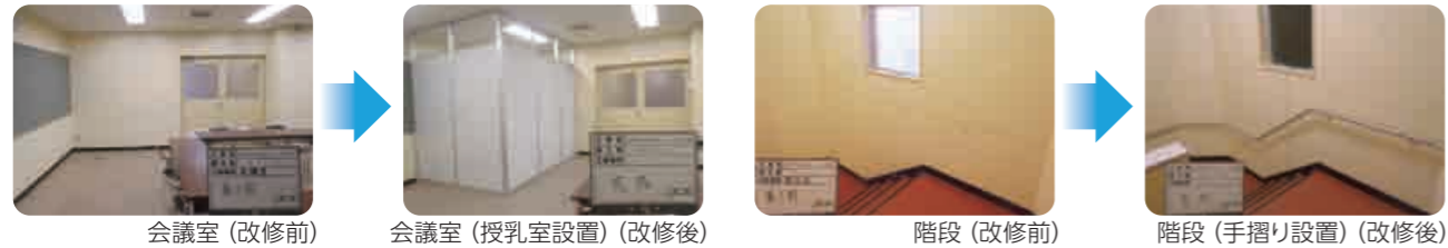
会議室(改修前) 会議室(授乳室設置)(改修後) 階段(改修前) 階段(手摺り設置)(改修後)
