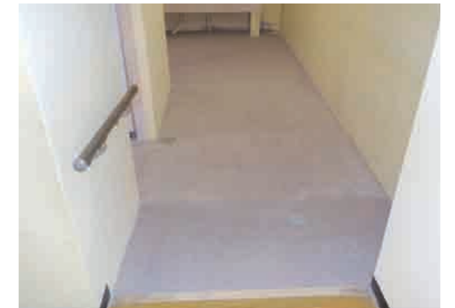
トイレ入口の段差解消
