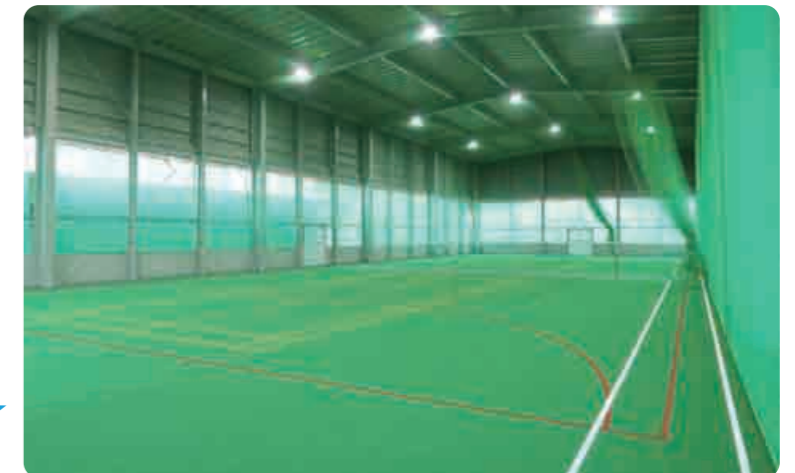
壁の半分は吹き抜けとなっていて快適に体を動かせます (改修後)
