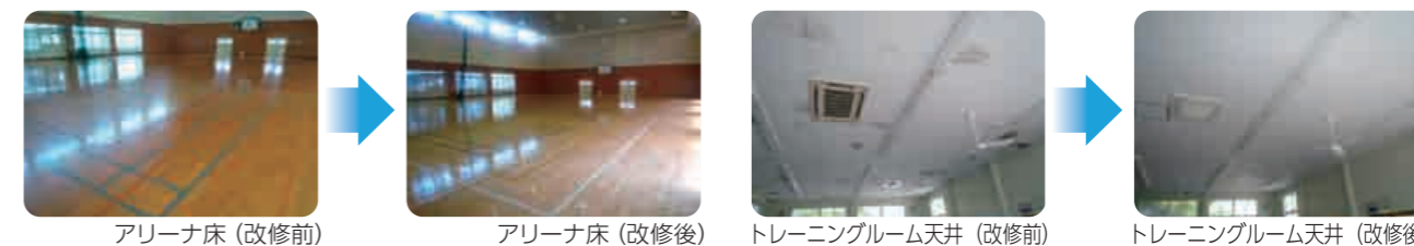
アリーナ床 (改修前)
