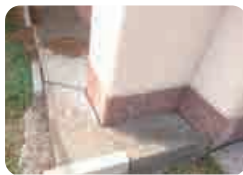
外部土間 (改修前)
