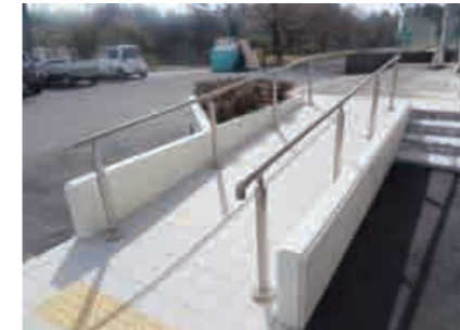
入口にスロープを新設すると共に玄関の段差も解消
