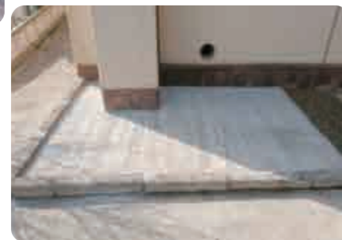
外部土間 (改修後)
