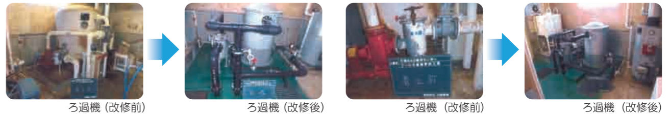
ろ過機(改修前) ろ過機(改修後) ろ過機(改修前) ろ過機(改修後)
