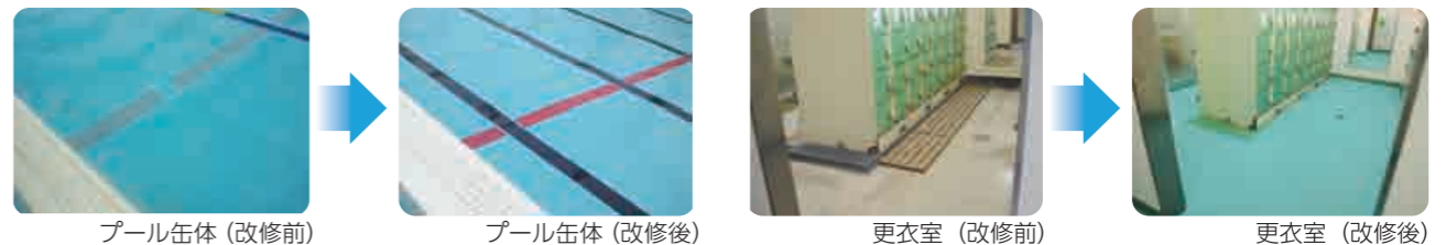
プール缶体(改修前) プール缶体(改修後) 更衣室(改修前) 更衣室(改修後)
