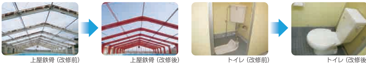
上屋鉄骨(改修前)
