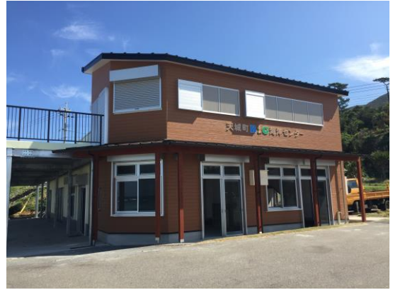
増築部分。一階にはテナントを設置
