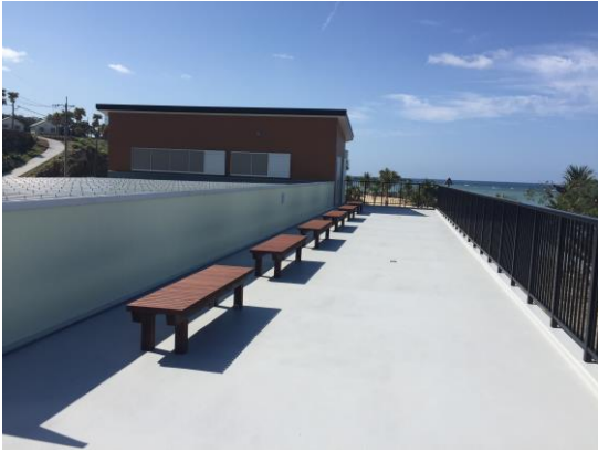
2階デッキ部分。デッキから2階内部への出入り可
