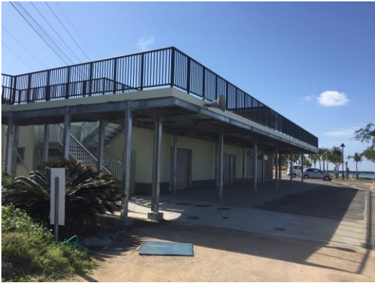
艇庫横より、デッキ下は日よけ等に使用
