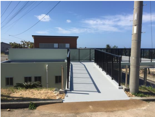
スロープ入口、駐車場から直接移動可
