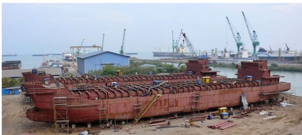
図 3-19 3500MT 油タンカーバージの建造
