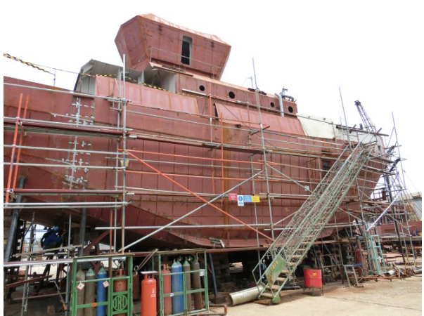
建造中のタグボート
