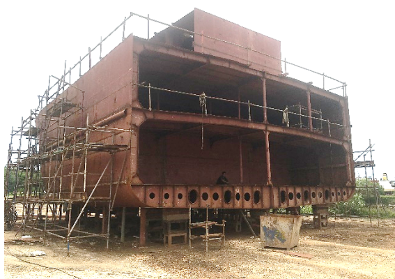
建造中の2000GT貨客船のブロック
