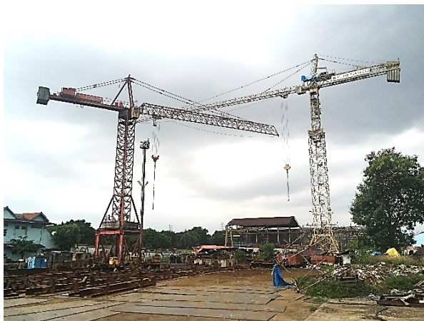
陸上の作業場とクレーン
