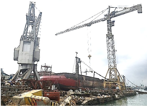
陸上で修繕中のバージ
