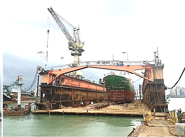
浮ドック内で修繕中の貨物船
