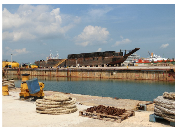
修繕中のバージと乾ドック
