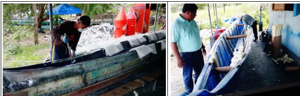
REGION III で BFAR 職員が建造中の FRP 漁船（バンカボート）
