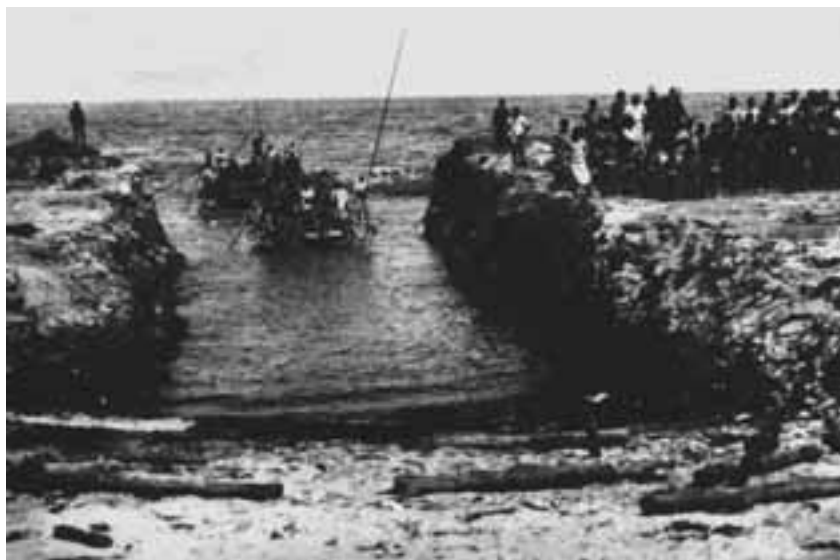
掘割(船着場) カツオ船2隻 人力櫓漕ぎ 帆船である。 海岸に転がって いる丸太は 船揚用コロ。 (明治41年)
