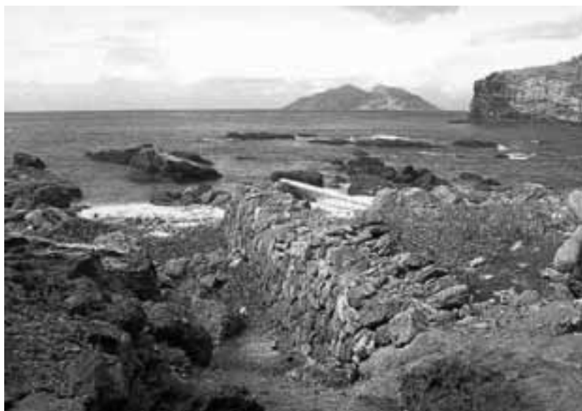
B地区山の手斜面に上る入口側の石積み。高波高潮から免れている。(仲間均 2002)
