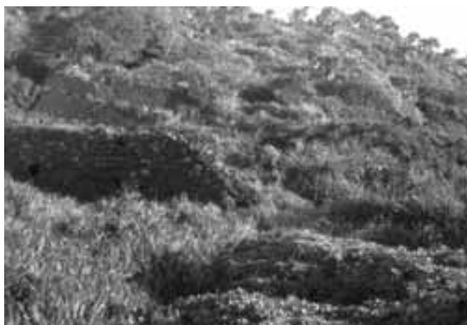
後方山の斜面に 石積みが見える。 「保存倉庫跡」の 石積みか？ (田中一郎 1953)
