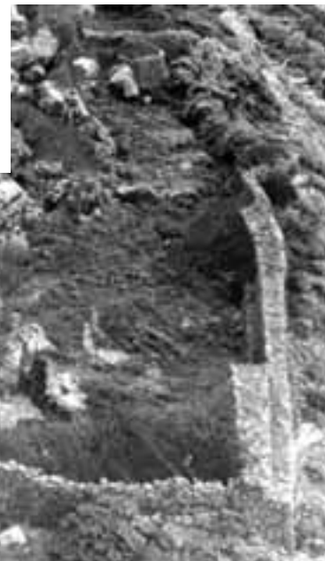
久場島古賀村跡の 道路遺構、 実に見事な石積み どこから、どこへ 何を運搬するために 造られたのだろうか。 (新納義馬 1980)
