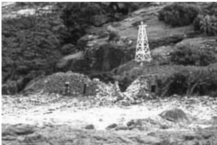
楼門東付近の傷が拡大、正面東半分の崩壊を引き起こした。（仲間均 2001）
