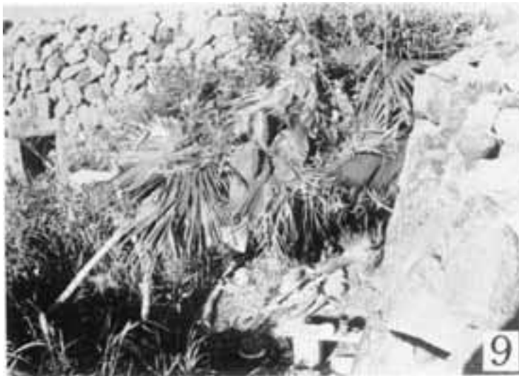
左は石積み正面楼門 右は袖垣の端 建物配置図見ると この袖垣の傍らに 水タンクがある (同上)
