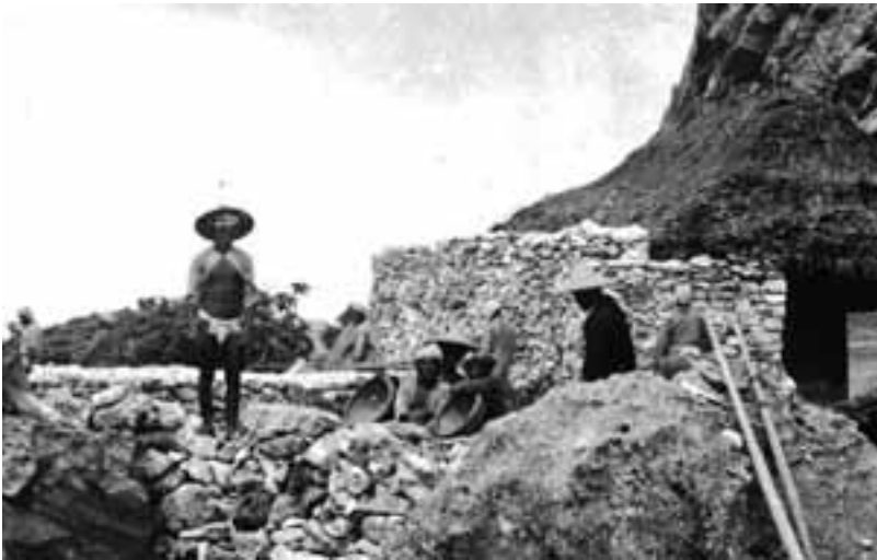
南小島古賀村建設工事 写真説明：「南小島 道路開鑿（三十三年）」とある。 (前出「藍綬褒章下賜の件」)
