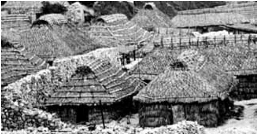
古賀村の茅葺屋根は押さえ竹、押さえ木や綱など頑丈に固定されている。これら茅葺家屋でも最低20年もつはずだが、石積みだけ残して、突然全部消え失せた。（前出明治41年）
