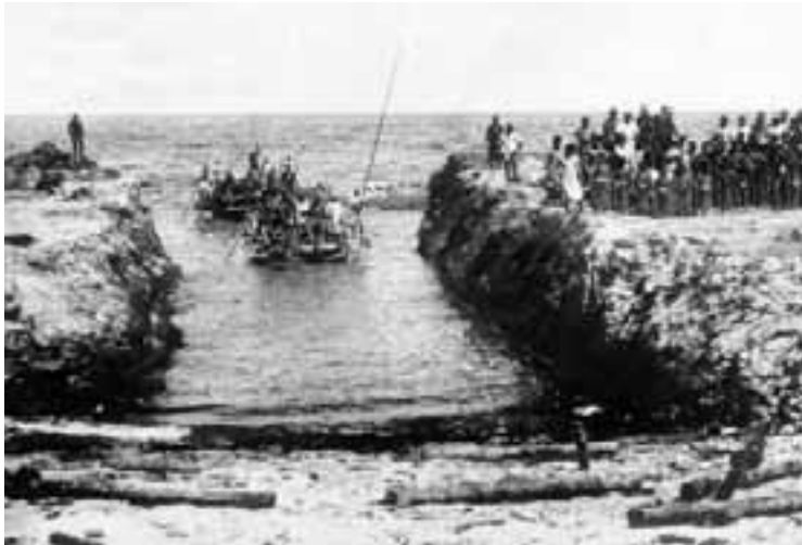
魚釣島古賀村海岸前の掘割。サンゴ礁の固い岩盤をダイナマイトで爆破、掘削して造った船着場。暴風時に備えて船揚場も設置されている。（明治41年）
