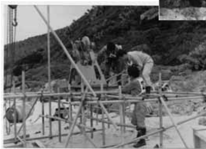
利用開発可能性調査で土質調査ボーリング(予定深度 20m)実施 魚釣島西岸でのボーリング掘削光景。 (尖閣諸島文献資料編纂会所有)
