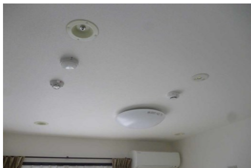
設置後(2階居室)
