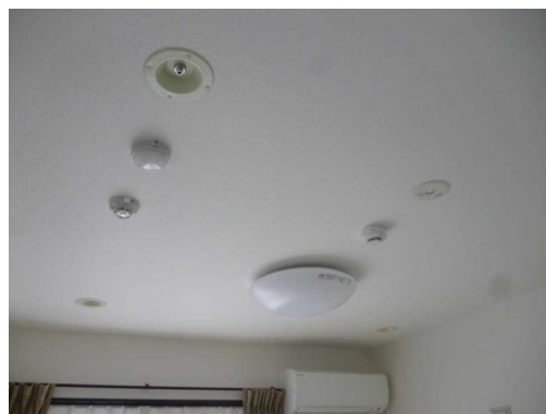
設置後(1階居室)
