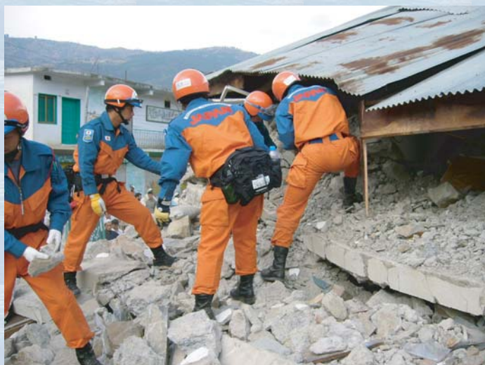
平成17年パキスタン地震における国際緊急 援助隊(救助チーム)による倒壊建物の捜索
