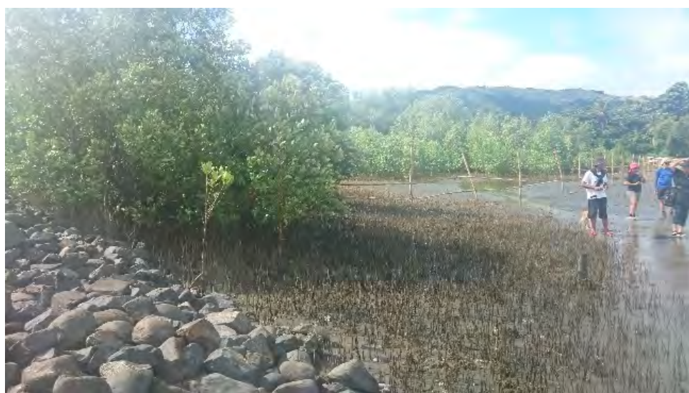
図 12：造成された防波堤背後に再生したマングローブ林
