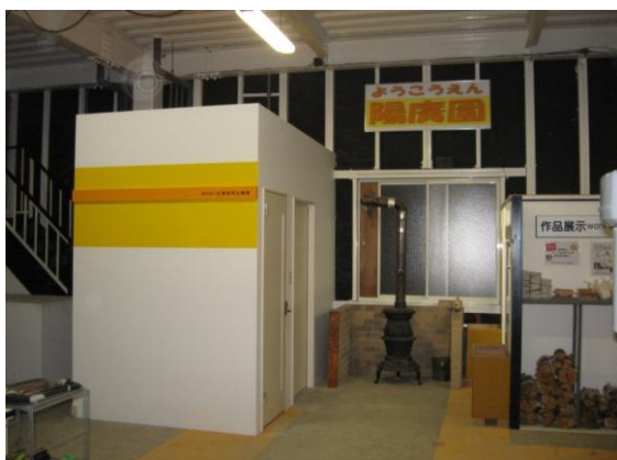
トイレ完成 全景
