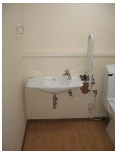
バリアフリートイレ (壁掛け洗面器・手摺 取付)
