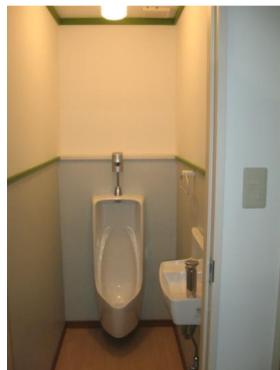
男性用トイレ(小便器・手洗器 取付)
