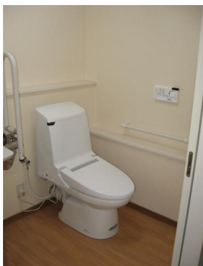
バリアフリートイレ (壁掛け洗面器・手摺 取付)
