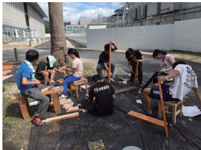
▲切り出した部材の加工、塗装
