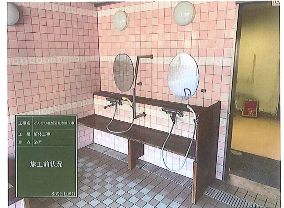
どんぐり機械浴室改修工事 着工前及び完成写真 着工前
