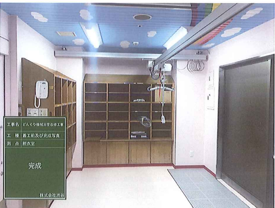
どんぐり機械浴室改修工事 着工前及び完成写真 完成
