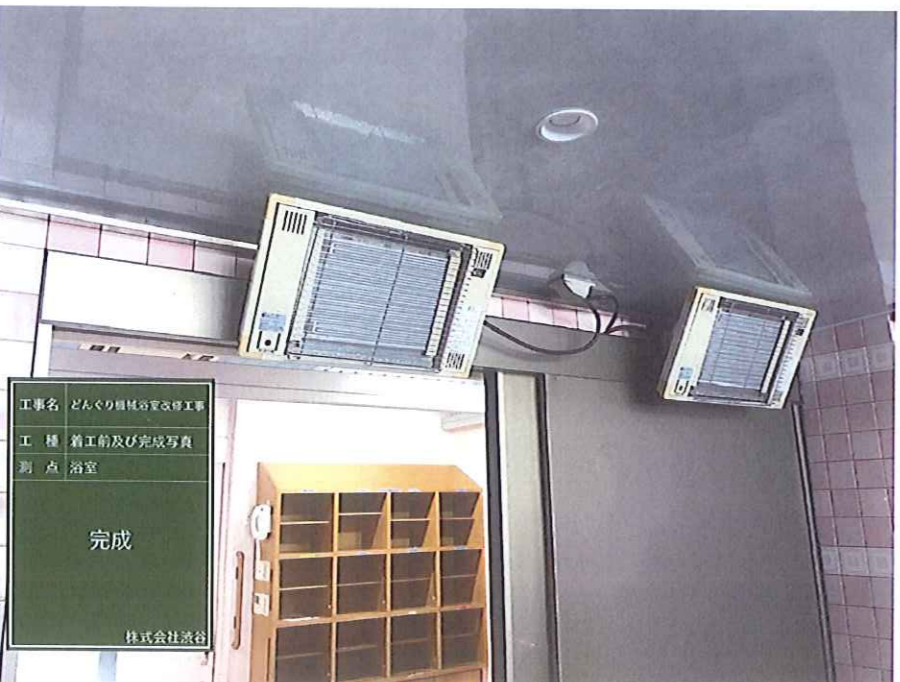
どんぐり機械浴室改修工事
