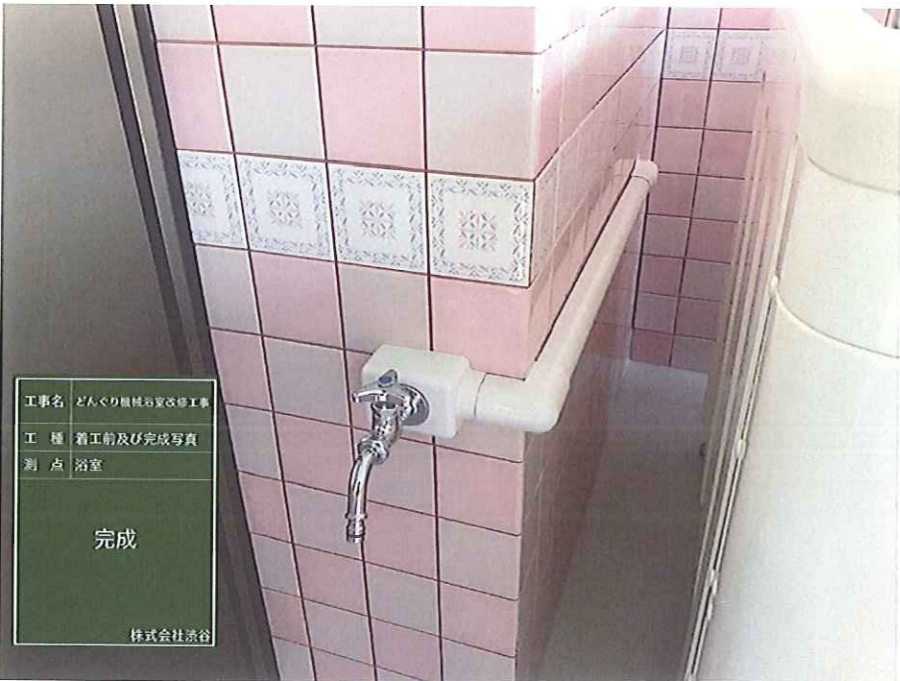
どんぐり機械浴室改修工事
