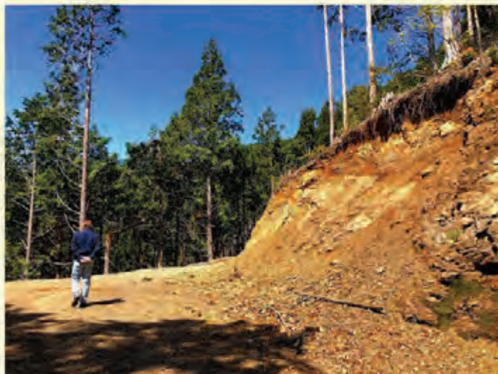
高性能林業機械を入れるための規模の大きい作業道 (左: 福井県 右: 高知県)
