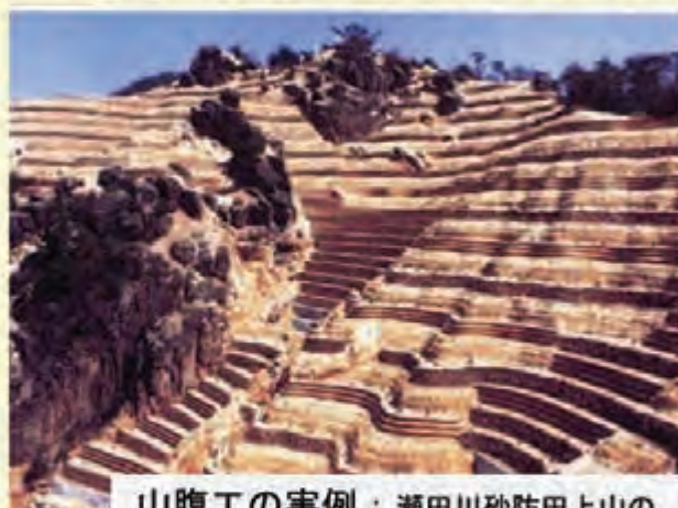
山腹工の実例：瀬田川砂防田上山の山腹工 出典：国土交通省
