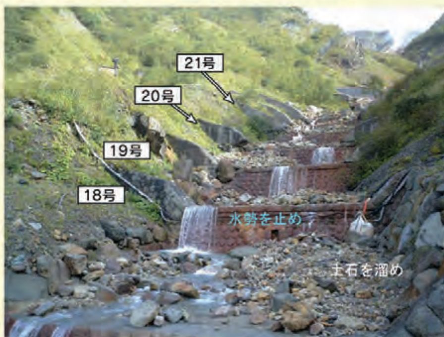
(基之助谷砂防堰堤群 出典：国土交通省)
