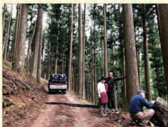
幅2.5m以下の作業道が高密な路網として頑丈に敷設されている。 (徳島県・奈良県) 壊れない道は「美しい道」でもある
