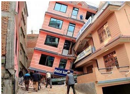
ネパール大地震で倒壊した建物
