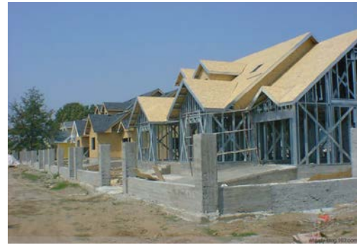
建設中のプレハブ住宅
