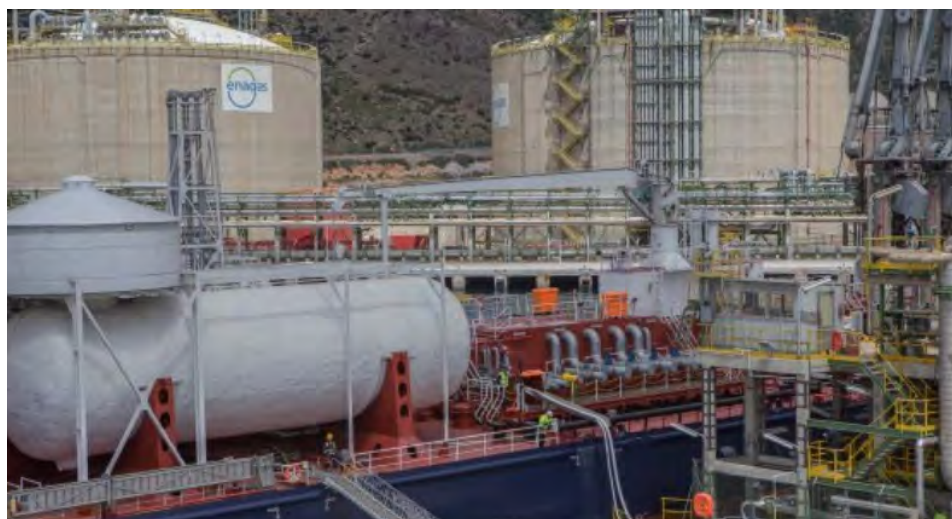
カルタヘナ港 LNG バンカリング（ターミナルからタンカー「Damia Desgagnés」へ）
