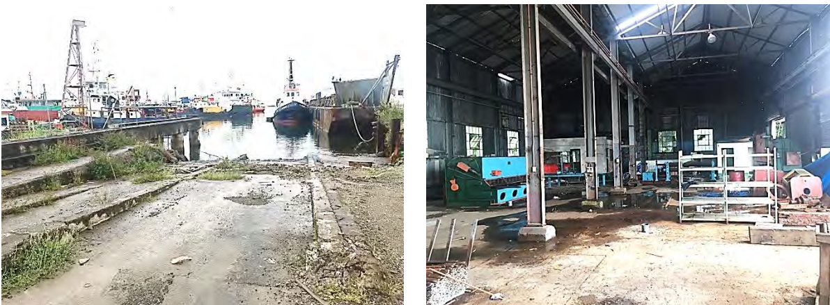
図 1-13 旧国営造船所が新造船建造していた造船所跡地
