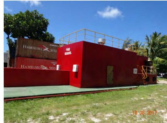
火災訓練実習棟
