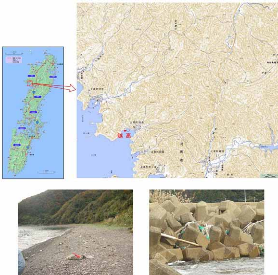
図 4.1-19 上県町越高の概況（調査日：平成 19 年 11 月 18 日）
