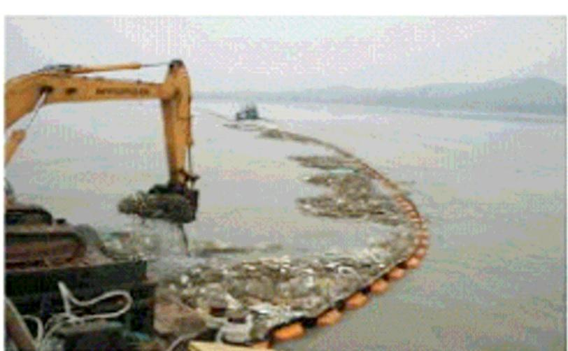
写真 4-6 浮遊廃棄物海洋流入遮断幕(ごみ遮断用網(フェンス))
