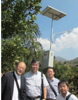
▲完成した太陽電池式街灯
