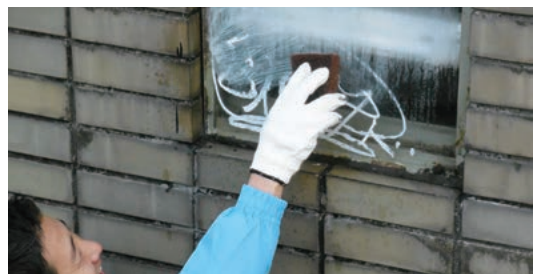
▲ペDESTリアンデッキの壁の落書き消し
