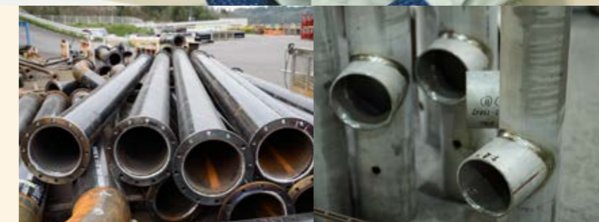
パイプの取り付け、溶接
