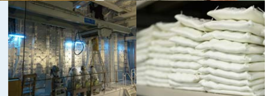
断熱材の取付
