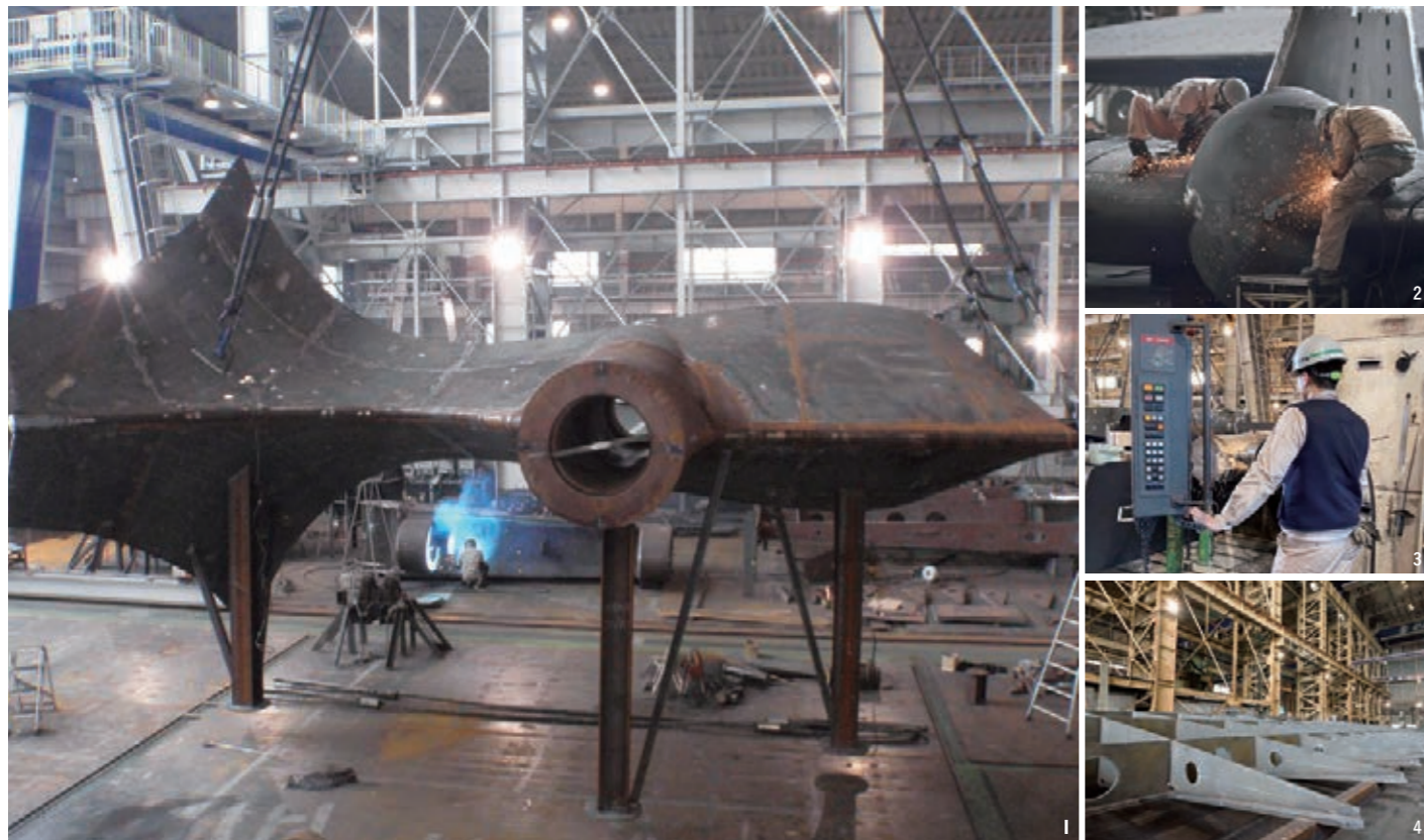
1. 船と同様にメインで手がける製品の1つ、スタンフレームは船尾の後方下部に取り付けられる。プロペラの軸が装着される大事なパーツの1つだ。 2. 同じ鉄工作业でも、こうした大型製品に携われるのが魅力だ。3. 機械加工で大きな製品を丁寧に仕上げている楽しさあり。 4. 大型の製品は、様々なパーツを1つずつ組み立てて完成させるチーム作業だ。
