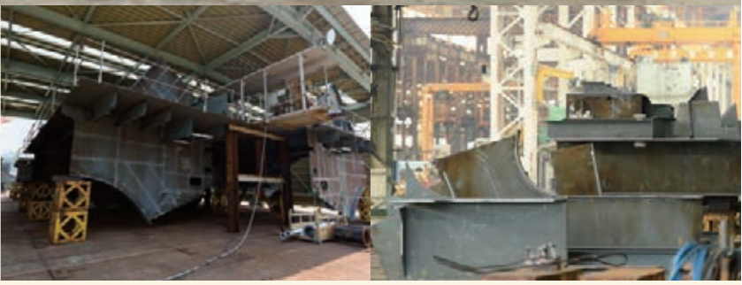
ブロック製造 船の内部の溶接
