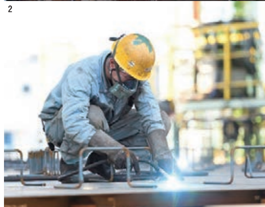
1. 外板を溶接中のイージス艦。一番耐圧が要求されるプロペラ周りのブロックなどを担当している 2. 港の中のケーソン(防波ブロック)を溶接中 3. JMU 磯子造船所内に工場がある 4. ケーソンの高さはビル6、7階ほど、巨大!
