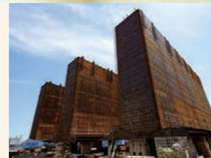
ビル6、7階くらいの高さの巨大なケーソン
