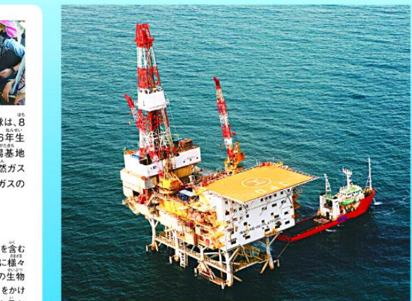
岩船沖プラットフォーム(日本海洋石油資源開発(株)提供)
