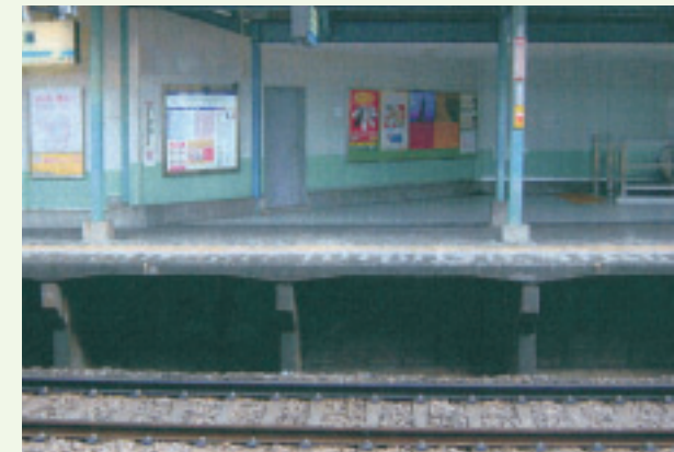
救出現場（ホーム下のスペース）
