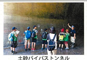
土砂バイパストンネル
