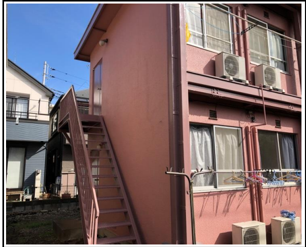
寮棟・外部鉄骨階段・扉塗装
