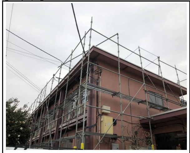
寮棟・外壁塗装・鉄骨塗装（足場）
