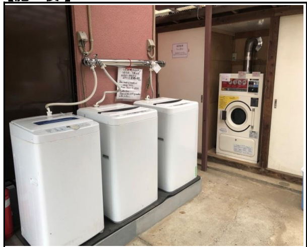
寮棟～食堂棟間・洗濯機置場移設
