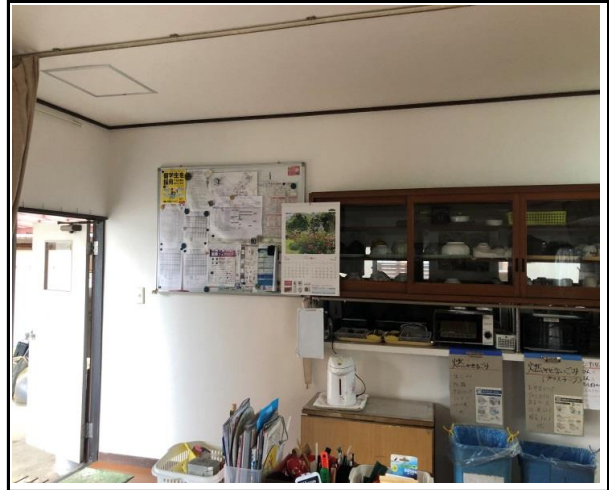
食堂棟・食堂壁クロス張替・床CF張替
