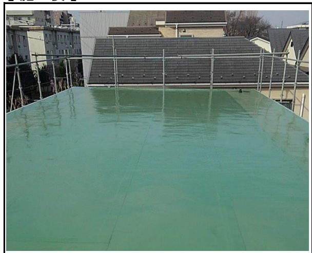
寮棟・屋根防水補修・保護塗装
