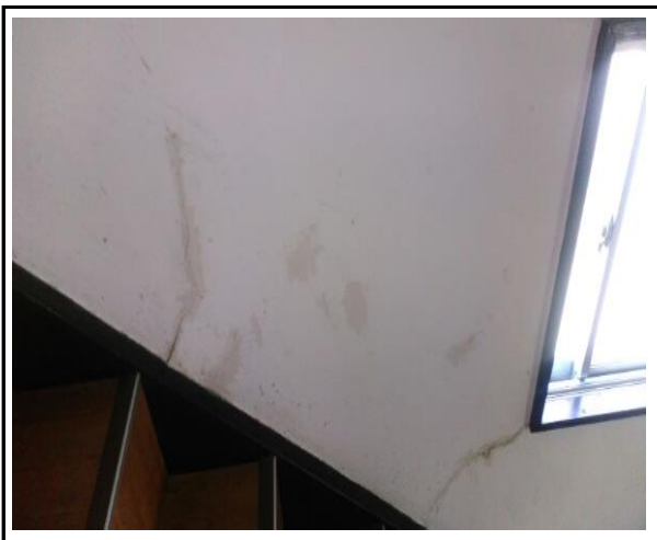
寮棟・内階段壁塗装・床CF張替
