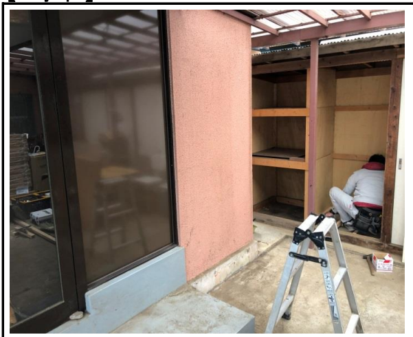
寮棟～食堂棟間・洗濯機置場移設
