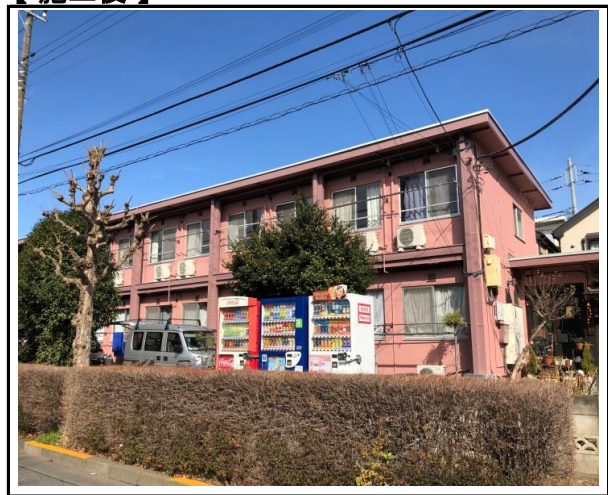
寮棟・外壁塗装・鉄骨塗装
