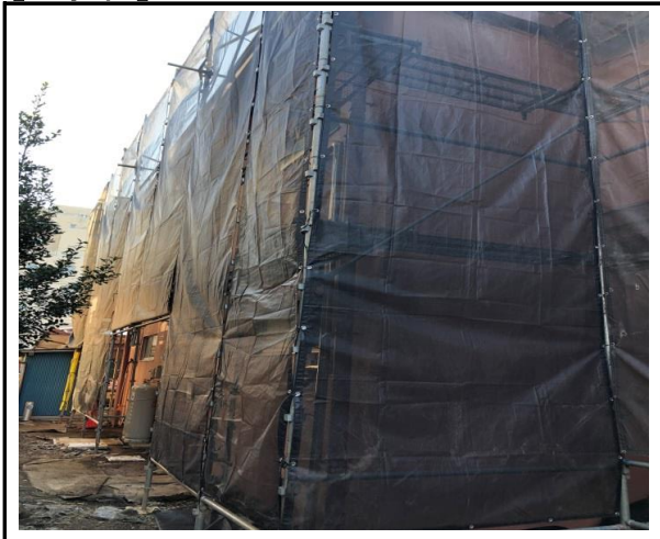
寮棟・外壁塗装・鉄骨塗装（足場）
