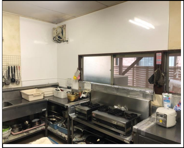
食堂棟・台所・壁修理
