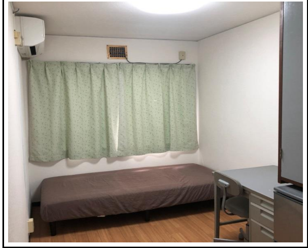
寮棟・寮室壁クロス張替・床フローリング張替
