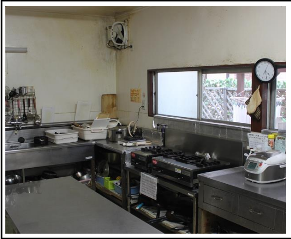
食堂棟・台所・壁修理
