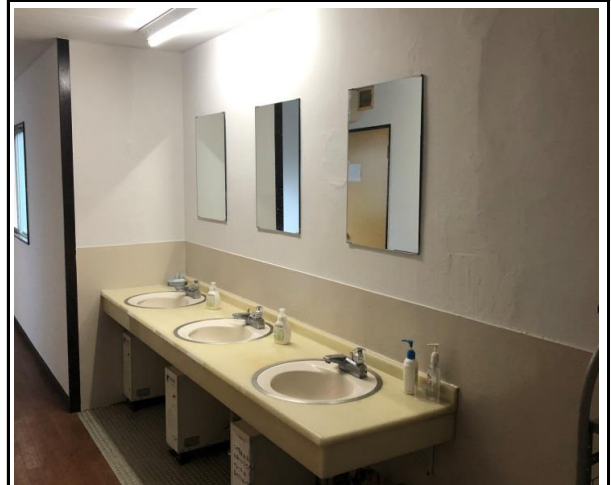
寮棟・廊下壁天井塗装・床CF張替
