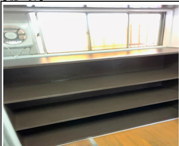
食堂棟・風呂場・脱衣室・壁塗装
