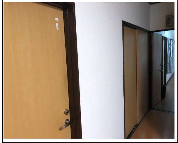
食堂棟・会議室壁クロス張替・床CF張替
