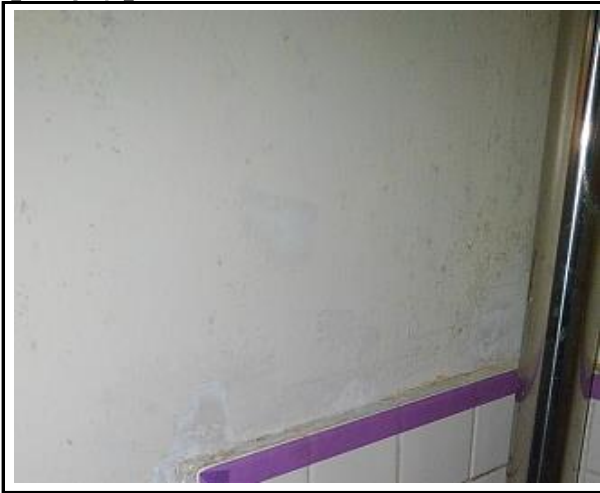
食堂棟・風呂場・脱衣室・壁塗装
