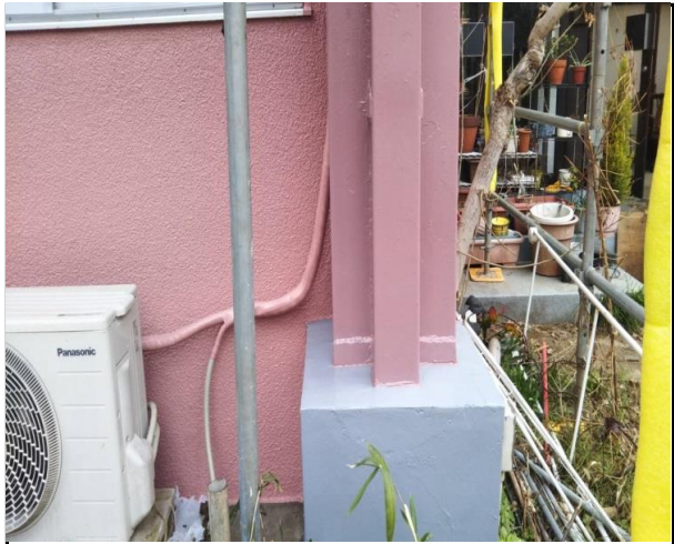
寮棟・鉄骨柱・梁塗装
