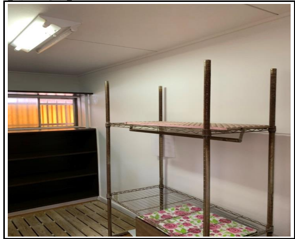
食堂棟・風呂場・脱衣室・壁塗装
