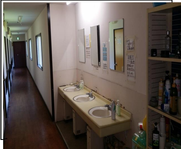
寮棟・廊下壁天井塗装・床CF張替
