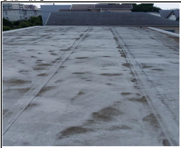
寮棟・屋根防水補修・保護塗装
