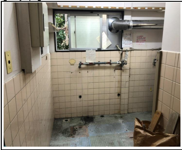
寮棟・シャワールーム・トイレ増設
