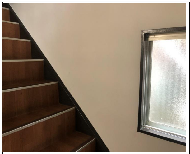
寮棟・内階段壁塗装・床CF張替
