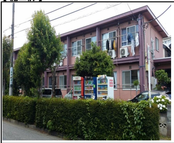
寮棟・外壁塗装・鉄骨塗装
