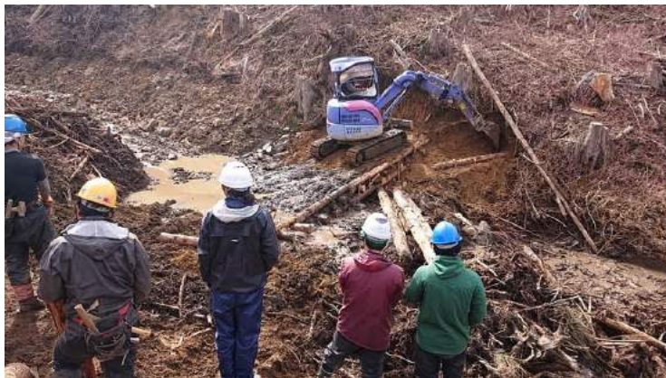
写真 谷波り（洗い越し）施工作業
