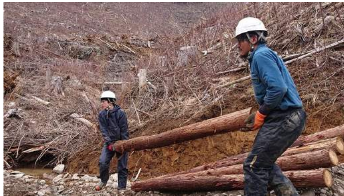
写真 木組み施業作業
