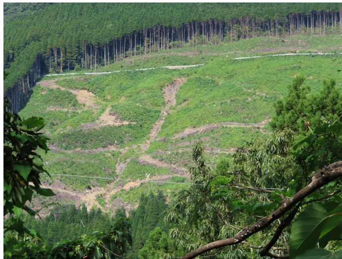
写真 皆伐跡の作業道が原因となり崩壊が始まっている
