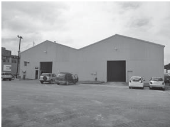
トランジット貨物用保管倉庫
