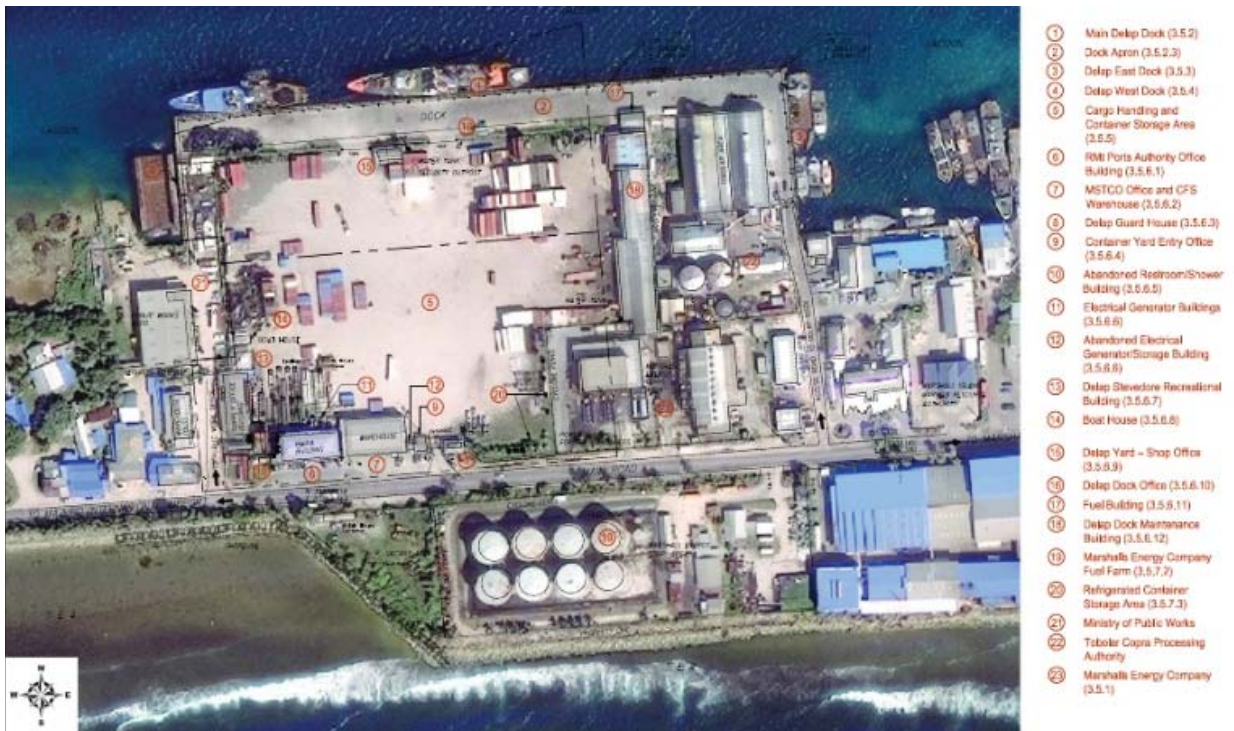
図 1-22 マジュロ港デラップ・ドックの全体写真
