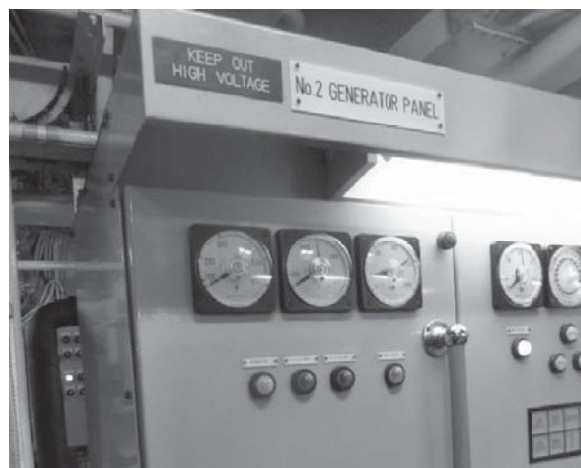
C 号 故障中の 2 番発電機スイッチボードと要交換のサーキットブレーカー
