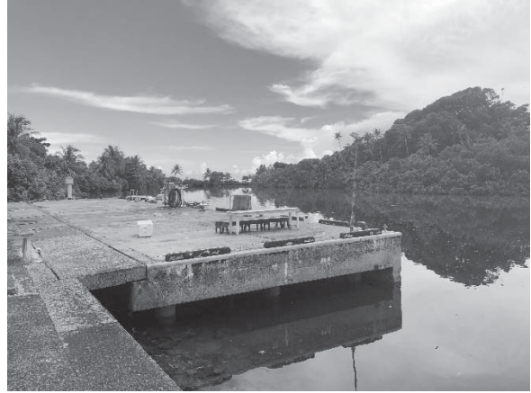
漁業海洋資源局の専用岸壁（レラ港）
