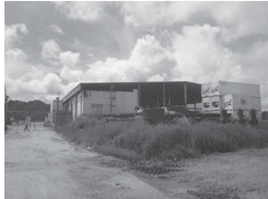
旧太平洋諸島マグロ漁業協会が 所有していた冷凍冷蔵施設
