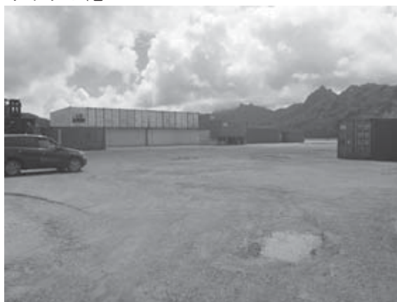
屋外コンテナ蔵置施設
