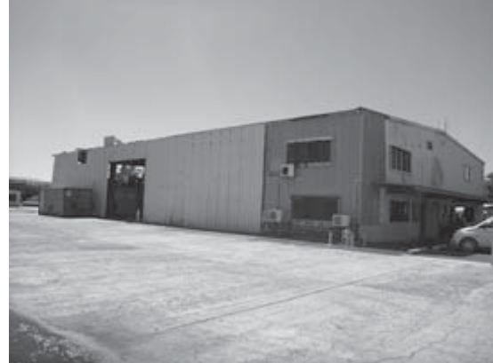
トランジット貨物倉庫
