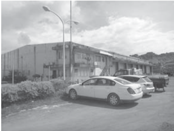
トランジット貨物保管倉庫
