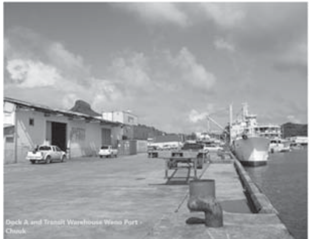
A岸壁とトランジット貨物用倉庫
