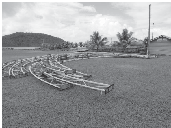
船台屋根の骨組み
