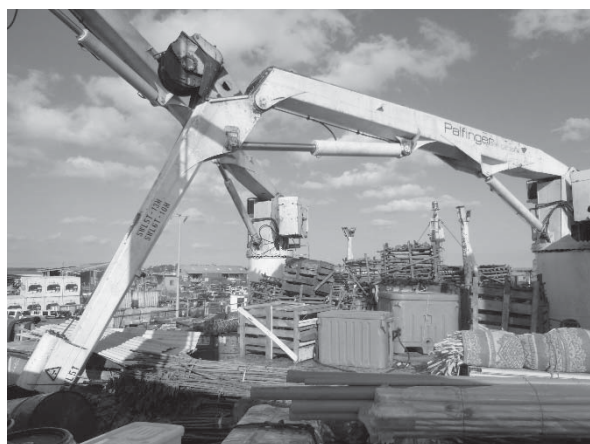
不稼働クレーン（右）と稼働クレーン（左）
