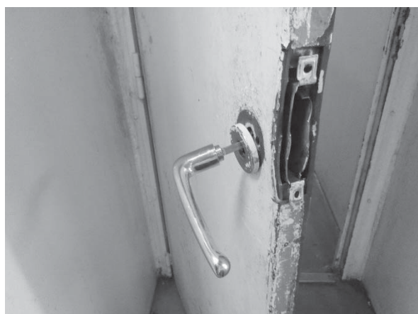
壊れているドアの取っ手と鍵（非常に多くのドアが故障中）
