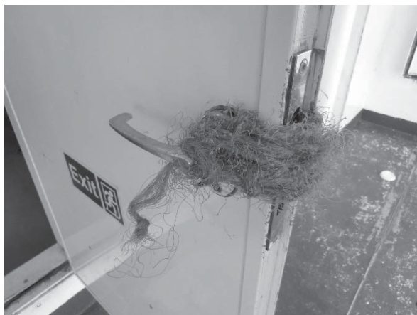
壊れているドアの取っ手と鍵（非常に多くのドアが故障中）
