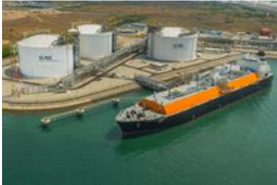
2014年5月時点の稼働状況
