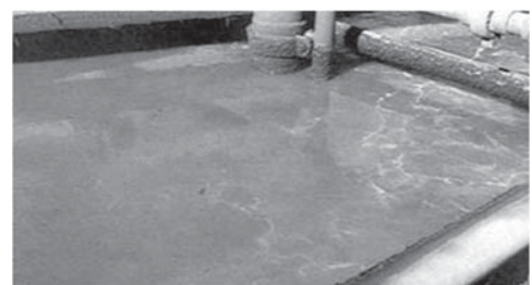
図 44 泥水ピットと掘削泥水
