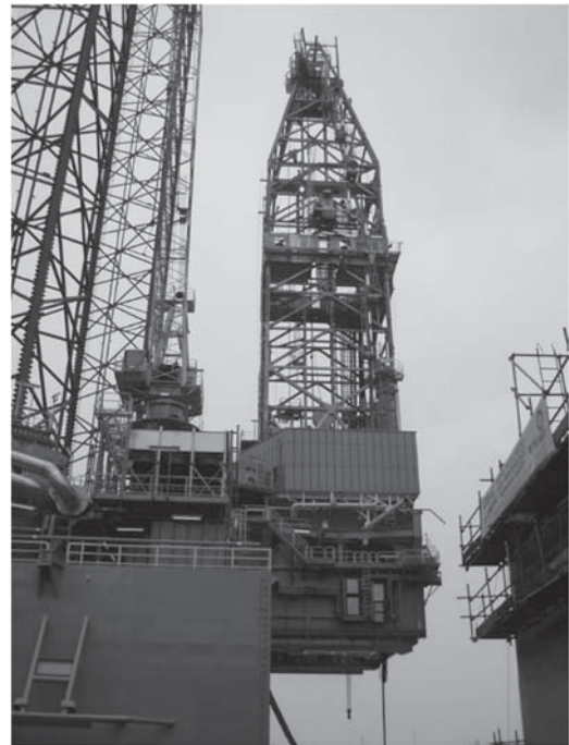
図 46 自己昇降式掘削装置のカンチレバー上に設けられたデリック
