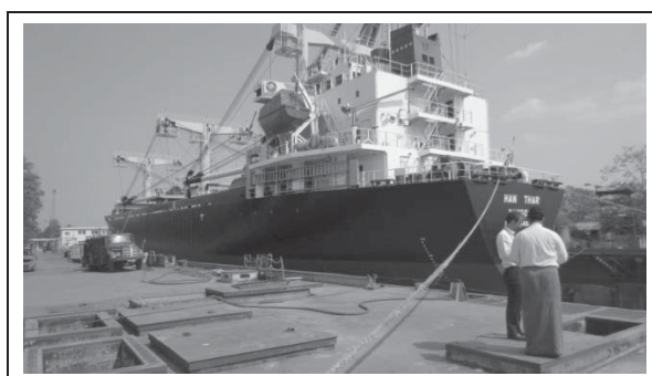
図 39 ミャンマー造船所の様子（ドライドックで修繕中の船舶）
