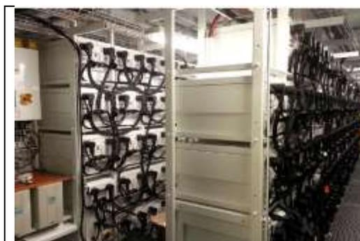
この蓄電池を本船の非常用発電機として使用するためには、更に17.2時間分の蓄電池容量(写真にある蓄電池パッケージを約17.2個分)が必要となり現実的ではない。電力貯蔵用蓄電池は一時つなぎの電源装置、一時的な電力加勢、DPS装置群のUPS、Harbor Useの限定的な給電ユニットとして用いるかという段階でしかない。
