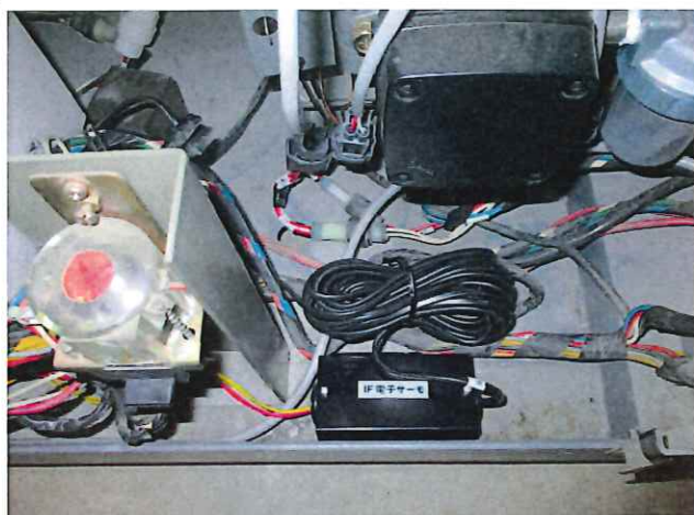
交換後 設置完了
