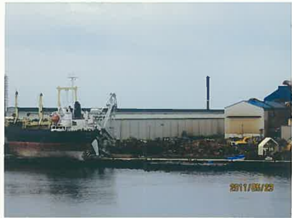
仙台港の状況
