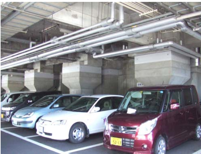
▲1階ピロティ駐車場
